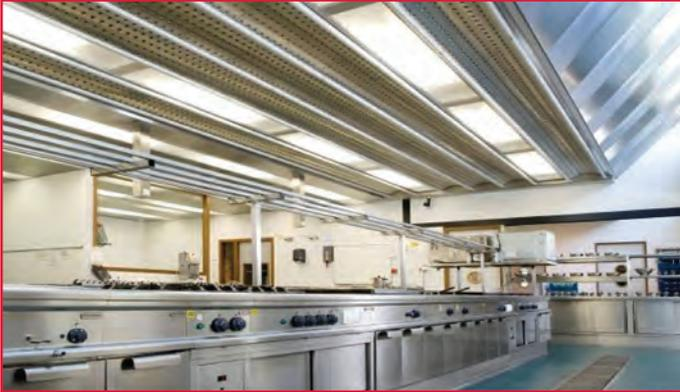
Одно- и двусторонние кассеты (для улавливания жира в зонах приготовления), каналы для стока жира, освещение, система подачи воздуха (гарантирует равномерное распределение воздуха и отсутствие сквозняков). Опционально: системы омывания, пожаротушения, ультрафиолетовой очистки воздуха
