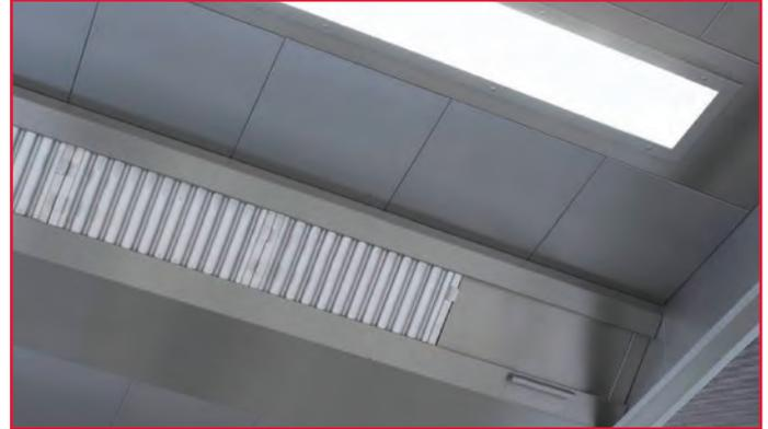
Оптимальное решение в интенсивных зонах приготовления. Извлечение жира с помощью фильтров, интегрированная система освещения. Высокая мощность вытяжки. Возможность комбинации с потолками Spantile.
